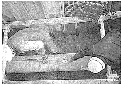
▲下水管を埋める作業
