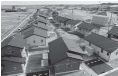
▲中島災害公営住宅 26戸を新築
