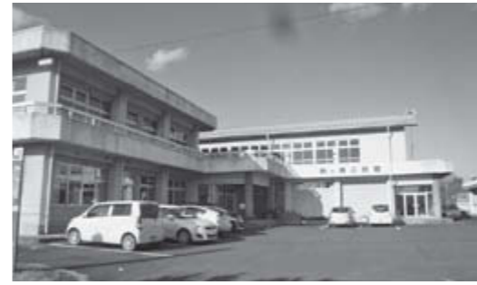
▲大ホール(体育館)の使用を停止している駒ヶ嶺公民館
