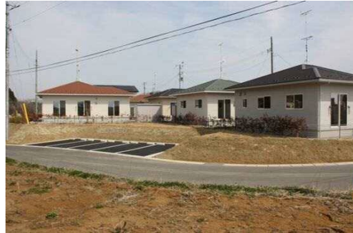
作田東町営住宅(6戸)
