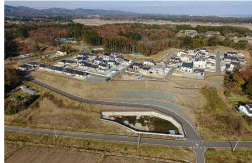
作田西団地（防集28区画、町営住宅9戸）
