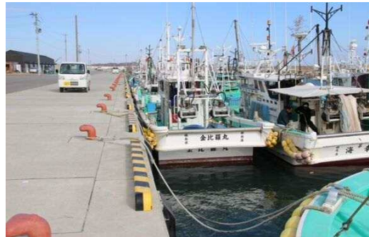
沈下した岸壁は復旧されました（釣師浜漁港）
