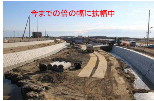
河川：役場東方の砂子田川、拡幅工事中
