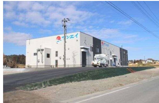
完成が近い水産加工施設（大戸浜地内）
