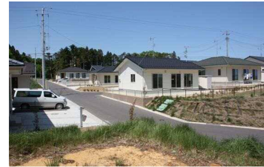
作田西町営住宅(9戸、空き1戸)
