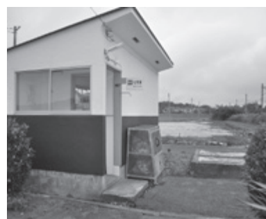
▲改修が望まれる駒ヶ嶺駅トイレ
