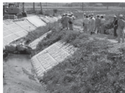
▲三滝川復旧工事
