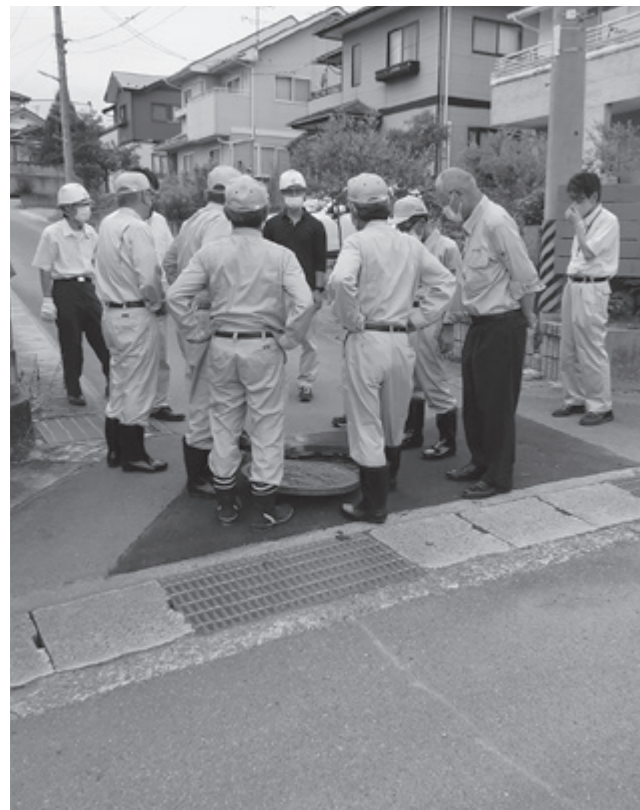
▲下水道被害状況調査
