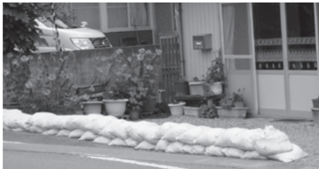
▲浸水防止の土嚢
