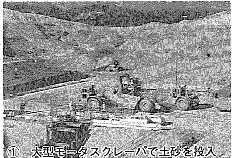
① 大型専用タスクレーパで土砂を投入
