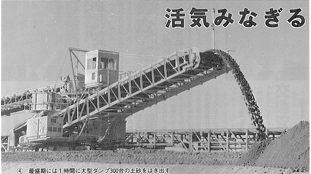
④ 最盛期には1時間に大型ダンプ300台の土砂をはき出す
