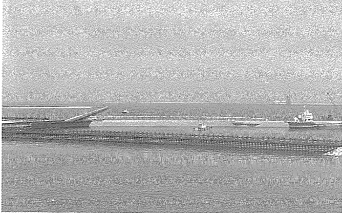
▲ 建設が進む5号ふ頭は、新地発電所への石炭荷揚げ基地として、約30haの工業用地造成を行っています。
