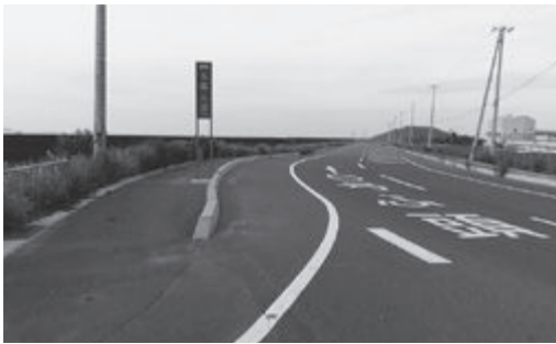
▲5号埠頭にアンモニア供給拠点が
