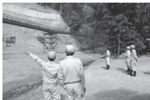
▲水管橋の改修工事も完了している
