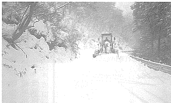
▶24時間体制で続けられた除雪作業
