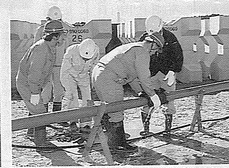
▲水道管の応急復旧訓練
