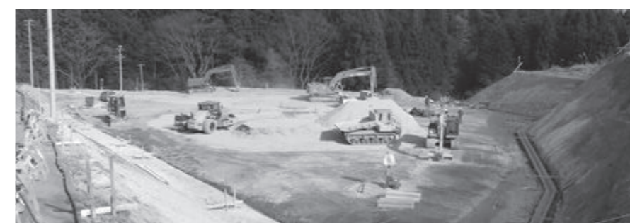
▲整備工事が進む鹿狼山駐車場
