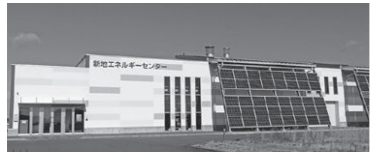
▲新地エネルギーセンター
