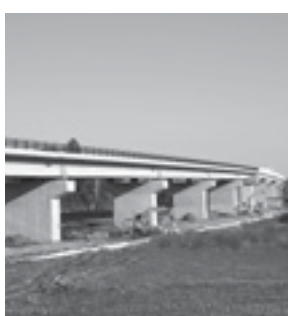
▲現在建設中の橋
