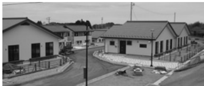
▲町営住宅愛宕団地では、3棟6戸が完成。平成20年度も引き続き建て替えを行います。
