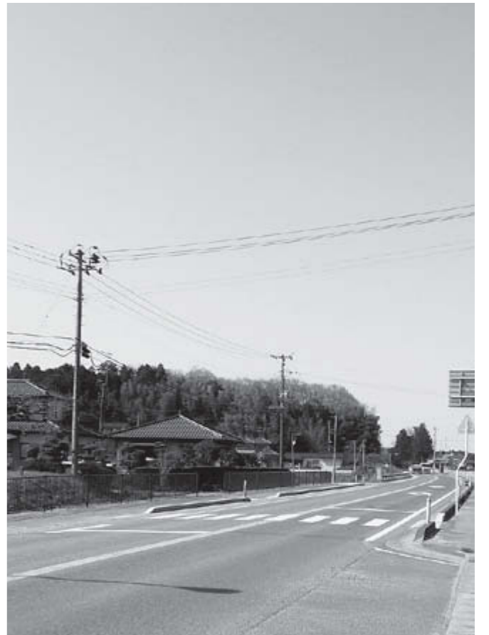
▲国道6号作田地区の一部完成した歩道と横断歩道
