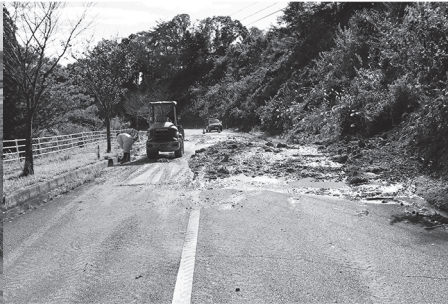
▲鹿狼山登山口周辺での土砂崩れ
