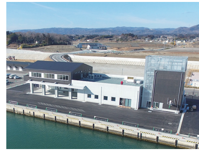
▲荷捌き施設と製氷施設の完成は漁業復興の第一歩となりました
