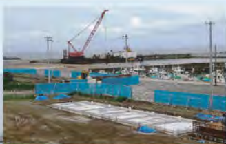
(工事中の漁具倉庫)
