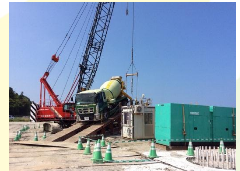
生コン車による高架橋杭の構築
