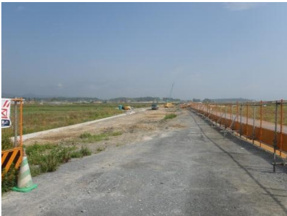
造成が完了した工事用通路
