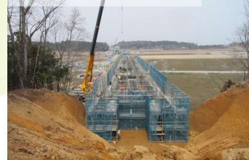
高架橋の梁構築工事の様子
