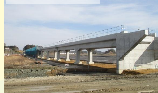
高架橋の梁構築工事の様子
