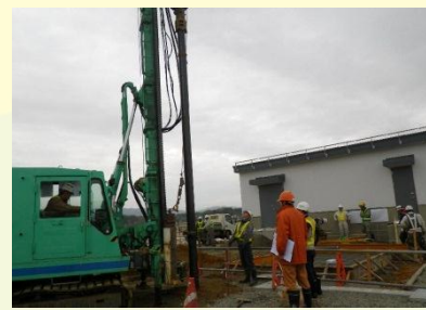
駅舎の杭工事中
