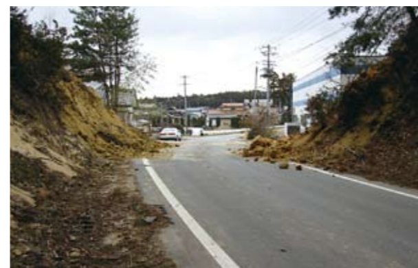
写真 2-17 土砂崩れの現場
