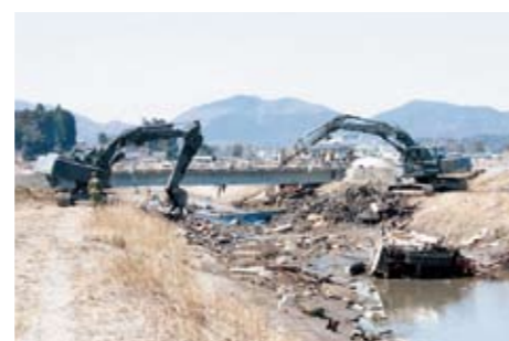
写真 2-127 濁川のガレキ撤去
