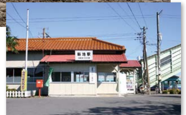
新地駅は、ホーム・跨線橋を残して駅および周辺一体が壊滅。停車中の列車も大破した。乗客は、たまたま乗り合わせていた警察官 2 人の誘導で町役場に避難し、乗務員も跨線橋に避難して無事であった
