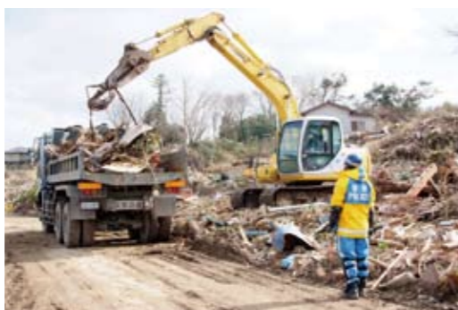
写真 2-100 重機を使ったガレキ除去
