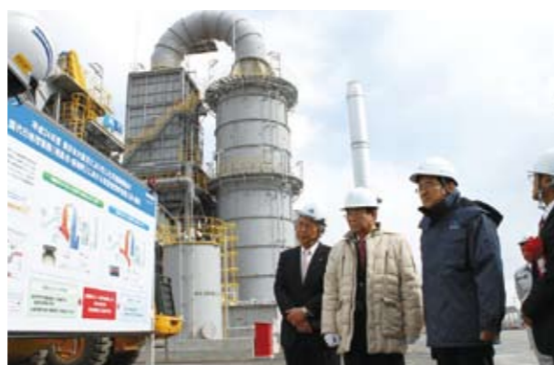
写真 2-321 災害ガレキ処理のための仮設焼却炉(相馬市光陽) 1日に約570トンのガレキなどが処理できる
