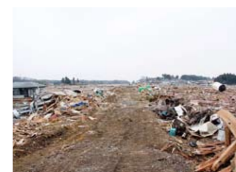
写真 2-98 ガレキを取り除き、作業用の道を確保
