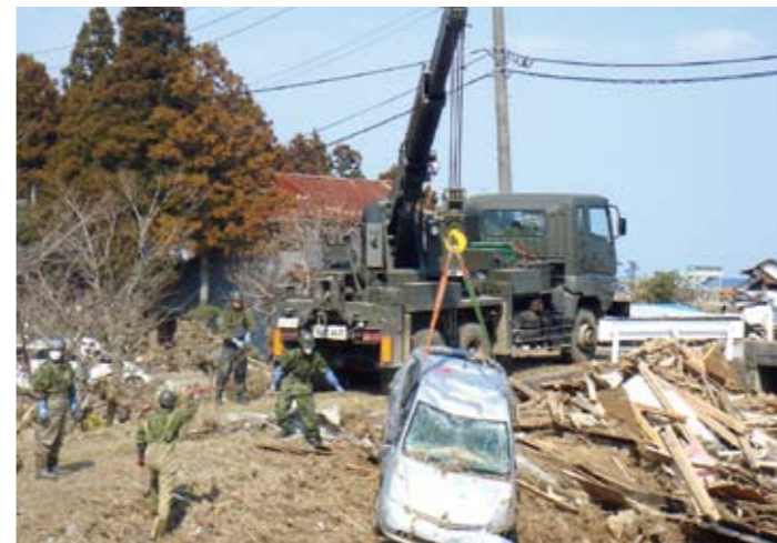
写真 2-114 水没車両の引き上げ作業
