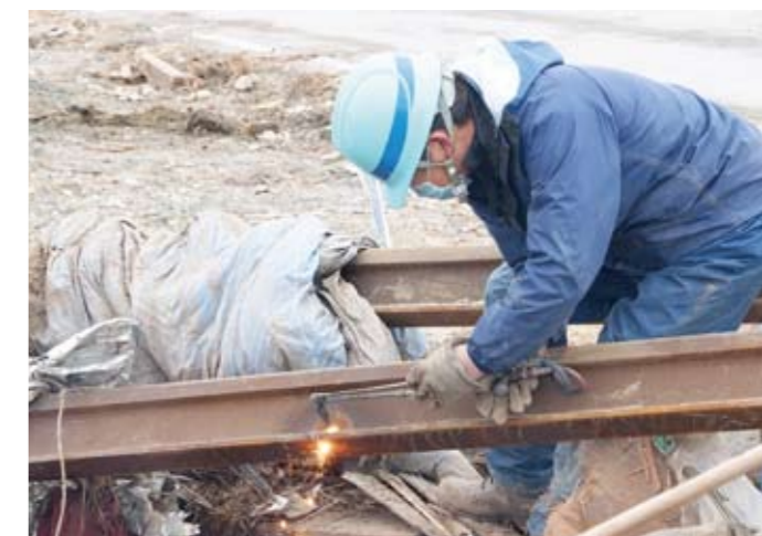
写真 2-96 流失したレールの切断と撤去
