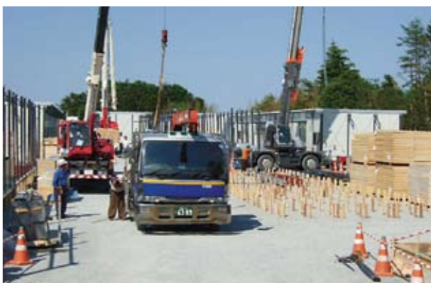
写真 2-189 仮設住宅建設
