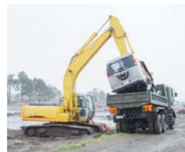
写真 2-160 新地駅前集積場 車の引き上げと 集積場への搬出
