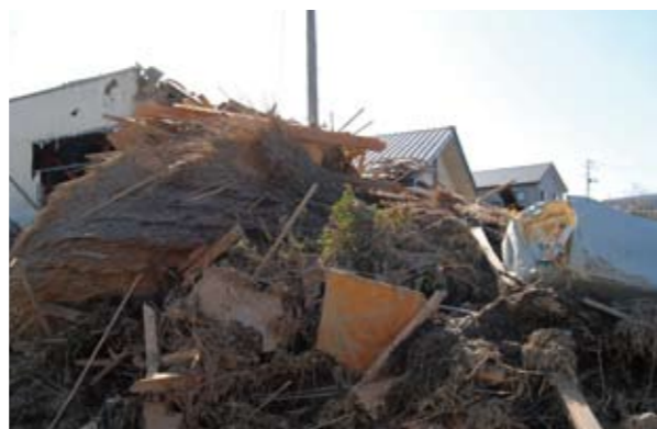
写真 2-73 津波により被災した観海堂の一部
