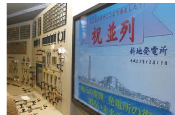
写真 2-231 新地発電所が発電を再開 津波により甚大な被害を受けたが、迅速な復旧工事により再開
