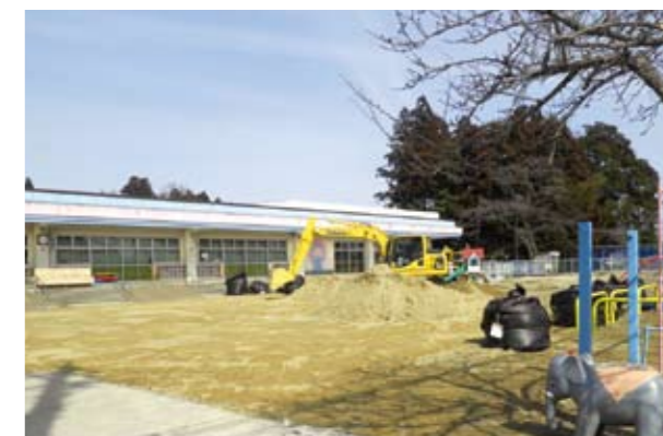
写真 2-266 重機で庭の表土を削る作業(駒ヶ嶺保育所)
