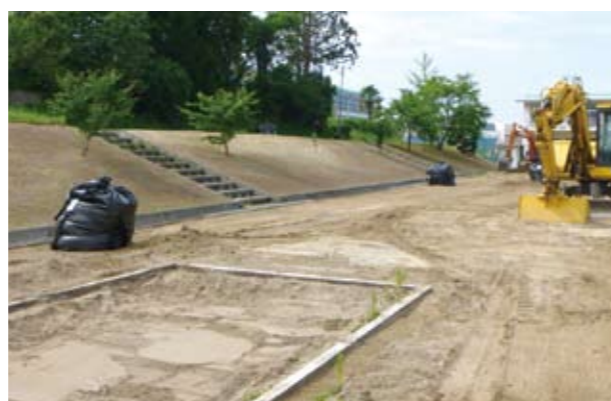
写真 2-289 重機で校庭の表土を削る作業（新地小学校）
