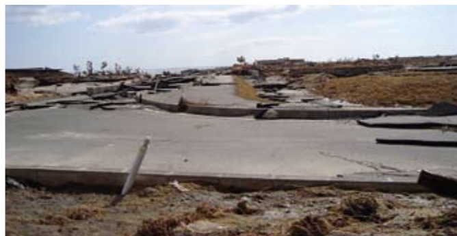
写真 2-54 沿岸部の 道路状況
