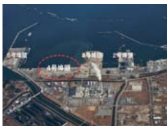
写真 2-348 LNG 基地建設地
