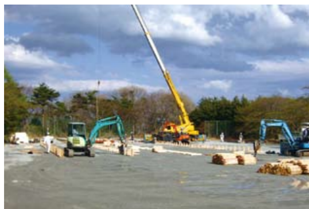
写真 2-182 仮設住宅の造成工事（前田）
