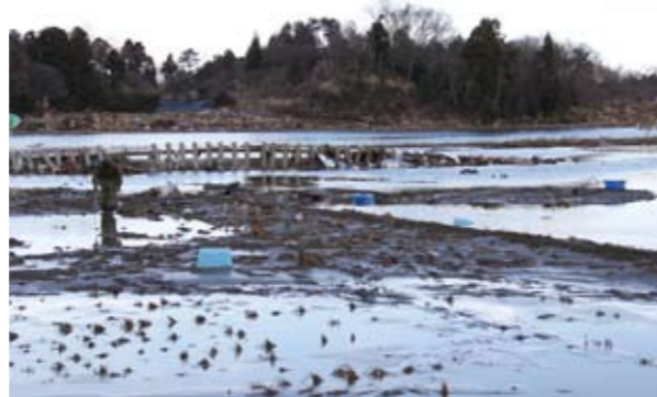
写真 2-78 流失した線路がめくれあがっている
