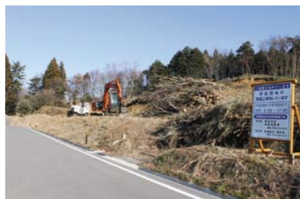
写真 2-316 造成工事が進む作田東防災集団移転団地
