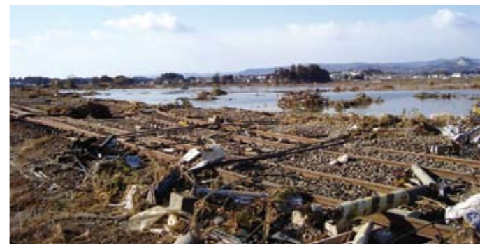
写真 2-53 線路を覆う ガレキ
