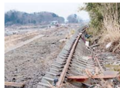
写真 2-105 小川踏切から見た線路。めくれ上がってしまっている
