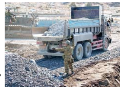
写真 2-88 津波被害地区の 重機による整備
