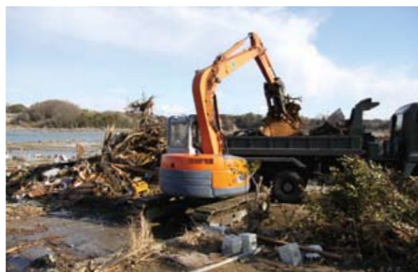
写真 2-79 重機で大きなガレキを撤去
