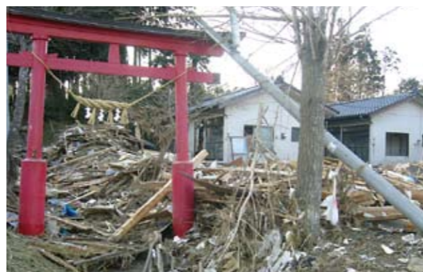
写真 2-56 津波によりなぎ倒された電柱
