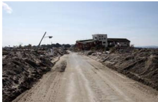
写真 2-83 ガレキを撤去し、通路を確保 (釣師)
