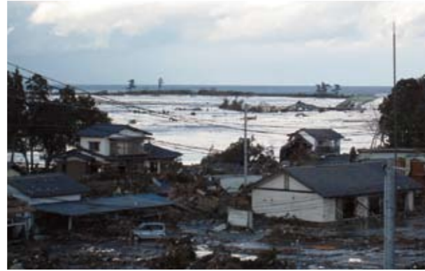
写真 2-18 新地駅の駅舎と車両も流失
