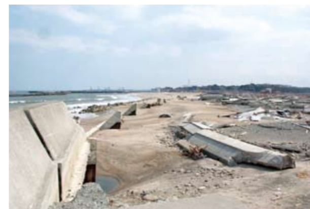
写真 2-178 堤防が損壊した釣師浜
