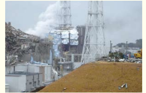
建屋の損傷が確認された4号機 [3月15日 東京電力(株)提供]
