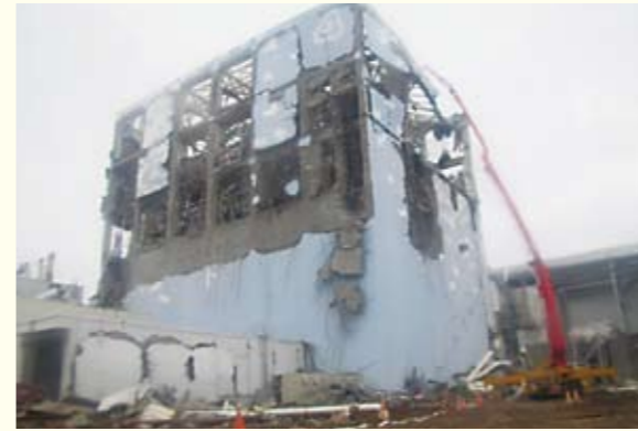
4号機への注水車からの放水 [3月22日 東京電力(株)提供]
